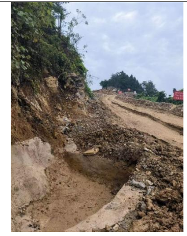
开采区排水沟
