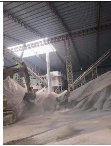
加工区除尘器
