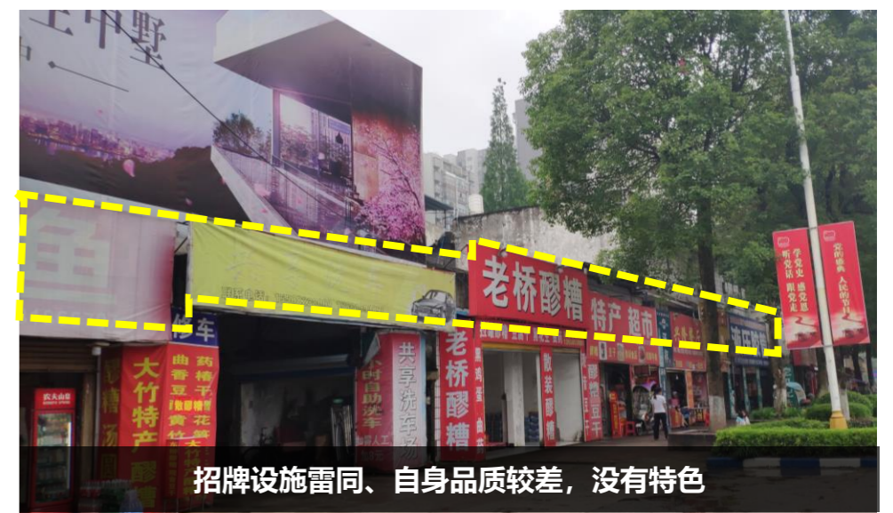
屋顶大型户外广告，破坏了建筑肌理美感
